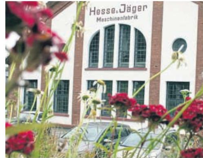
Im Sommer nicht mehr so heiß: Das denkmalgeschützte Schneckenhaus erhält eine neue Sonnenschutz-Verschattungs-Anlage.
